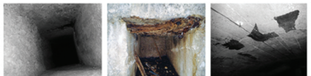
CANALI / SFALCI DI AERAZIONE CON I RESTI DI CENTINE E ARCHITRAVI LIGNEI (foto di un "ricovero blindato" privato esistente a Carrè)
